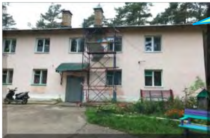
Установка лесов для выполнения работ по ремонту
