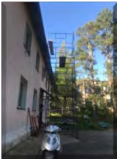
Установка лесов для выполнения работ по ремонту
